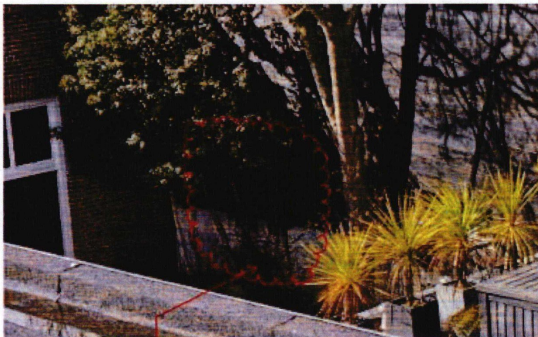
Bestaand raamkozijn buren voor ruim 50% weggetimmerd
