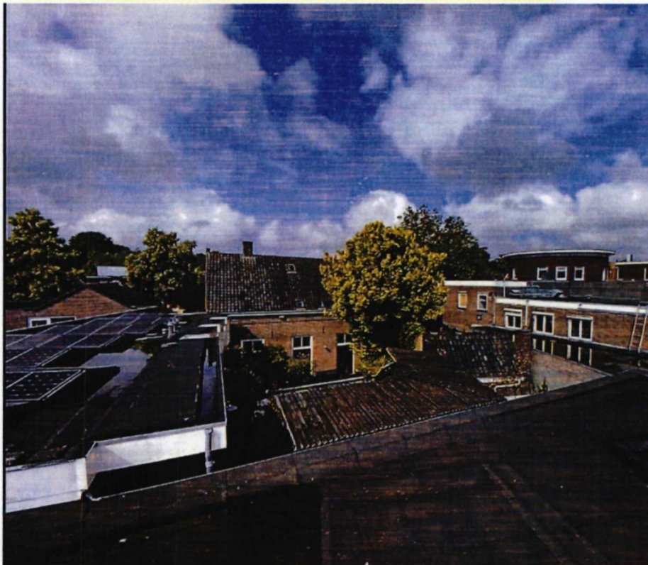
5. Positie 5 Achterkant tussen de aanbouw en terrasoverkapping
