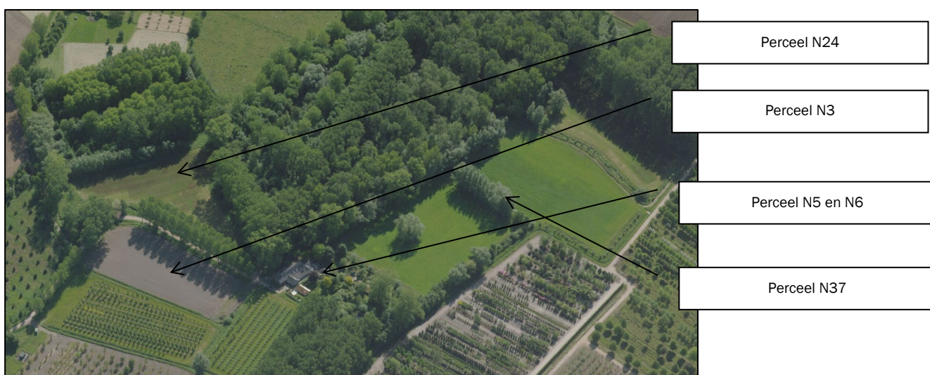
Figuur 11: Bestaande situatie vogelvluchtperspectief projectgebied (bron: cyclomedia.nl)
