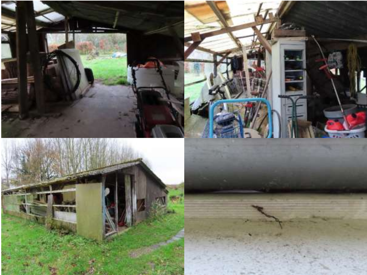
Figuur 8: Geen potentiële verblijfplaatsen voor vleermuizen aangetroffen. Bron: BNL advies.
