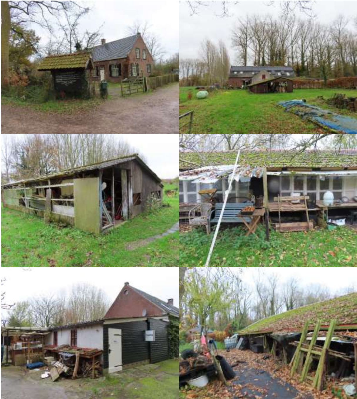
Figuur 3: Bestaande bebouwingen. Bron: BNL advies
