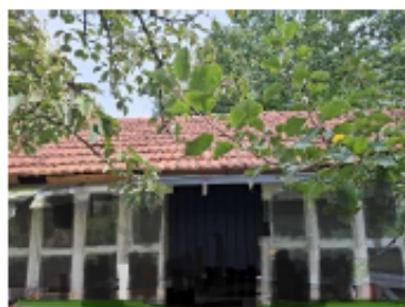
Zijaanzicht met dakpannen en raampartijen
